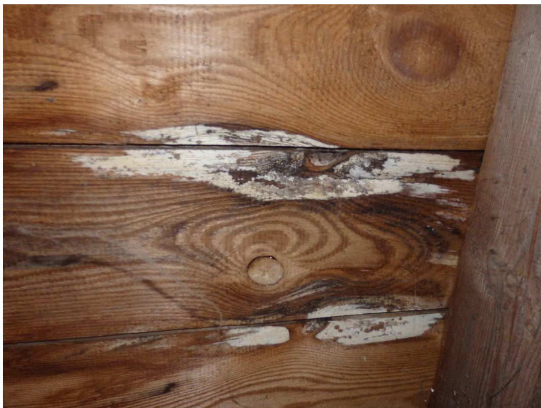
Kościół pw.. Matki Bożej Różańcowej w Koszalinie, deskowanie porażone grzybem domowym
